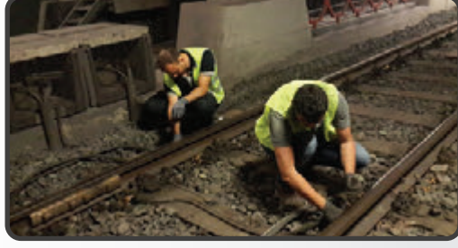
Test Ön Hazırlığı, Empedans Bond Bağlantılarının Yapılması
