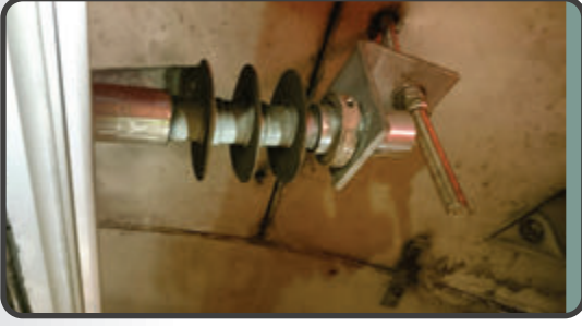
Makas bölgesindeki katener barasını taşıyan drop tüplerde de yükseltme işlemi gerçekleştirildi.
